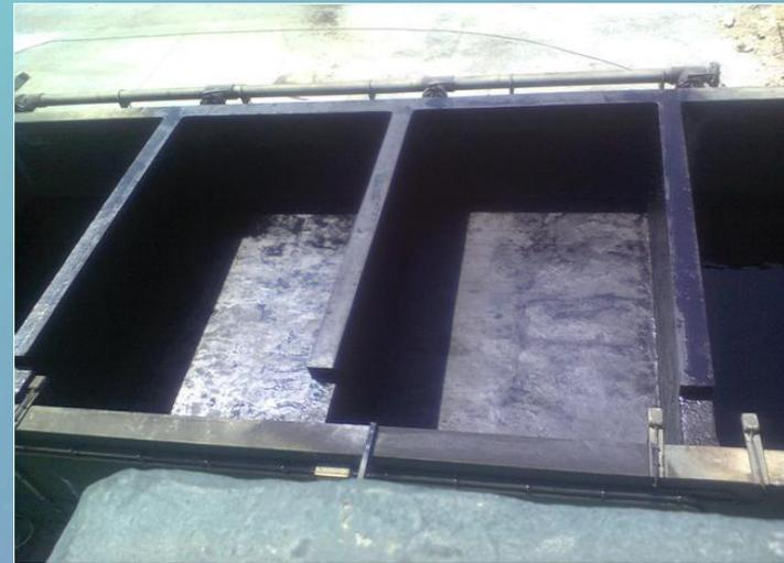
Foi realizada a picagem e reparação de alguns dos tanques, com a posterior aplicação de revestimento
