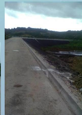
Implantação, de raiz, de um sistema de valeta para a condução de águas pluviais para os terrenos adjacentes
