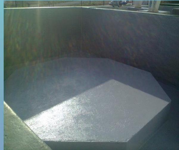
O maciço foi reconstruído e impermeabilizado, em conjunto com todo o interior da bacia de retenção
