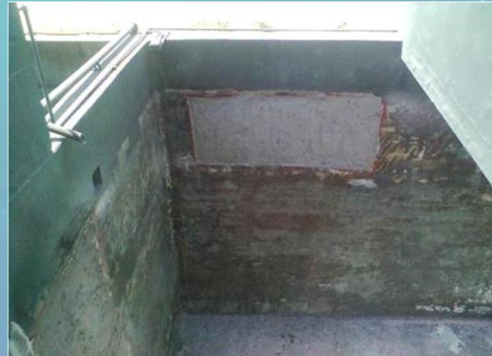
Realizou-se a picagem dos elementos degradados, incluindo reparação do ferro e posterior aplicação de argamassa adequada às condições de funcionamento do tanque
