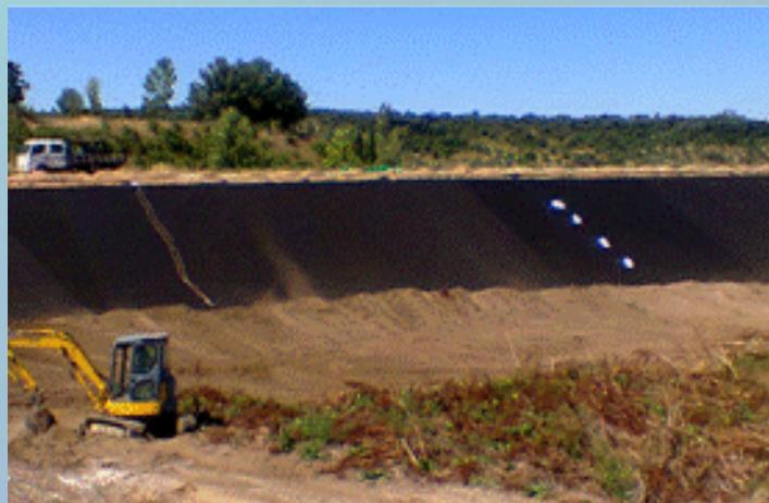
Recuperada a camada drenante dos taludes do Aterro de Lamas
