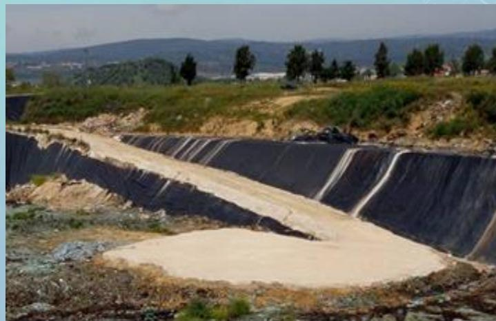
Com esta intervenção criaram-se condições para a circulação permanente de veículos pesados de descarga no fundo da célula
