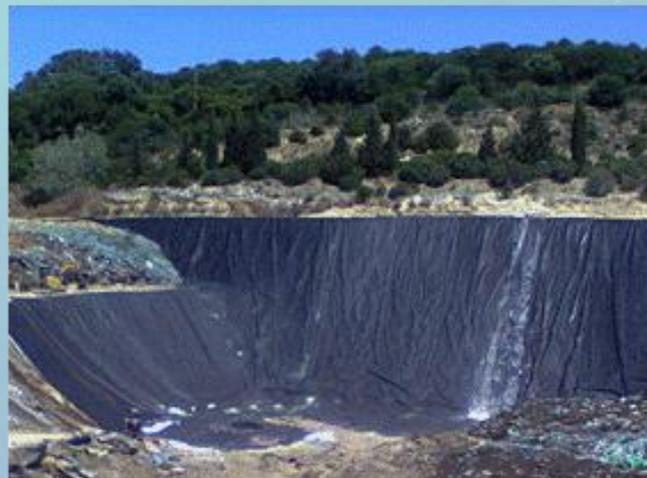
Com esta intervenção resolveu-se a fraqueza estrutural do talude nascente, através de um enrocamento devidamente estabilizado e posterior reposição da estrutura de impermeabilização
