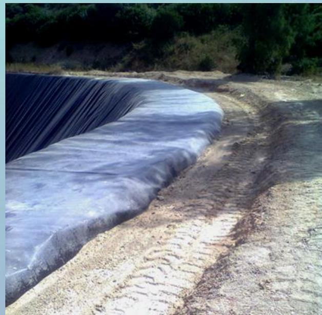
Procedeu-se ao corte da tela danificada e posterior soldadura de tela nova, tendo-se aumentado o comprimento de ancoragem
