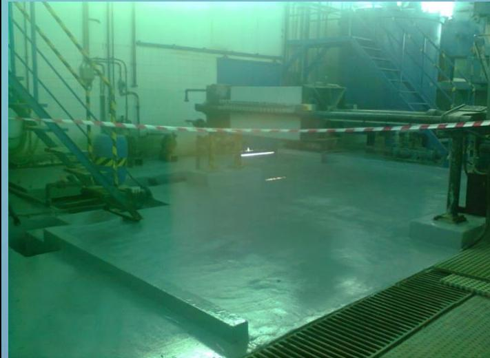
Procedeu-se à retirada da impermeabilização antiga e à reparação do pavimento, onde aplicável. Numa segunda fase, foi reposta a impermeabilização.
