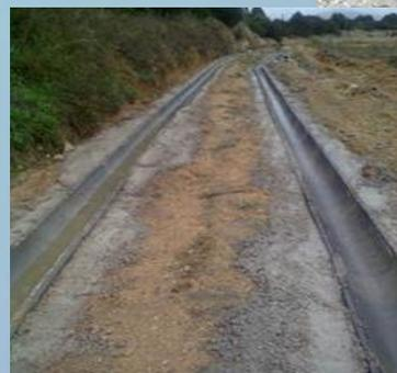
Com a recuperação do sistema de valetas, garantiu-se o afastamento das águas pluviais do interior do Aterro – realizando a sua drenagem para os terrenos adjacentes.
