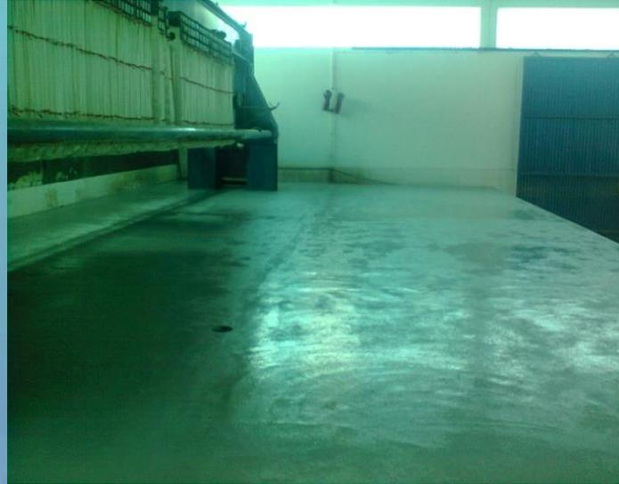
A intervenção realizada permitiu a regularização e posterior impermeabilização do pavimento
