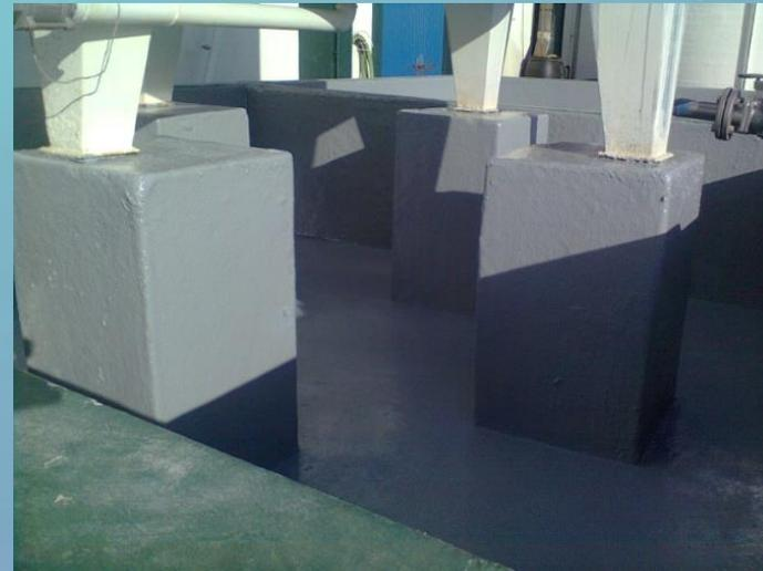
Após a intervenção nas paredes internas da bacia de retenção do ácido, foi reforçada a impermeabilização dos elementos.
